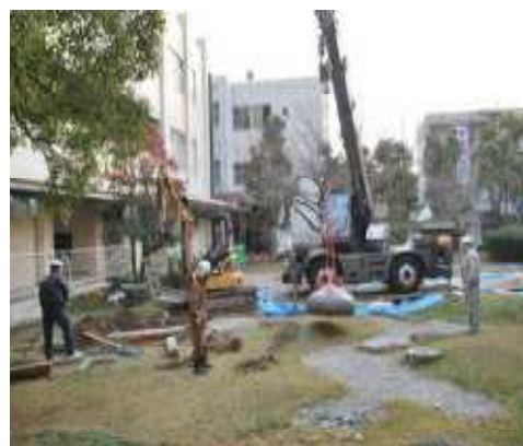
【着々と進むエレベータ設置工事】
