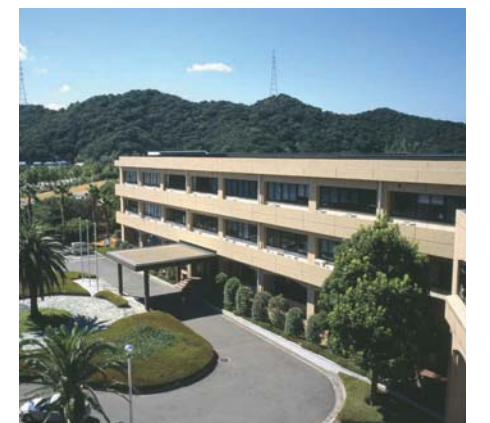
本部棟 Administration Hall
