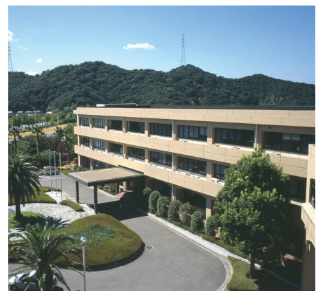
本部棟 Administration Hall
