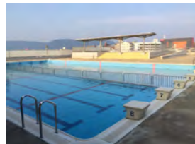
奥：小プール（最深約1.0m） 手前：大プール（最深約1.5m） ※1～4レーンは水深調整台を設置し、水深を約1.3mにしている
