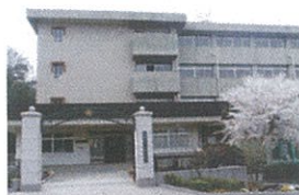
設置機種：EB-485WT(21台) 設置：黒板上部の壁 投影素材：黒板上に取りつけたスクリーン
