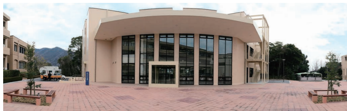
コアステーション Core Station
